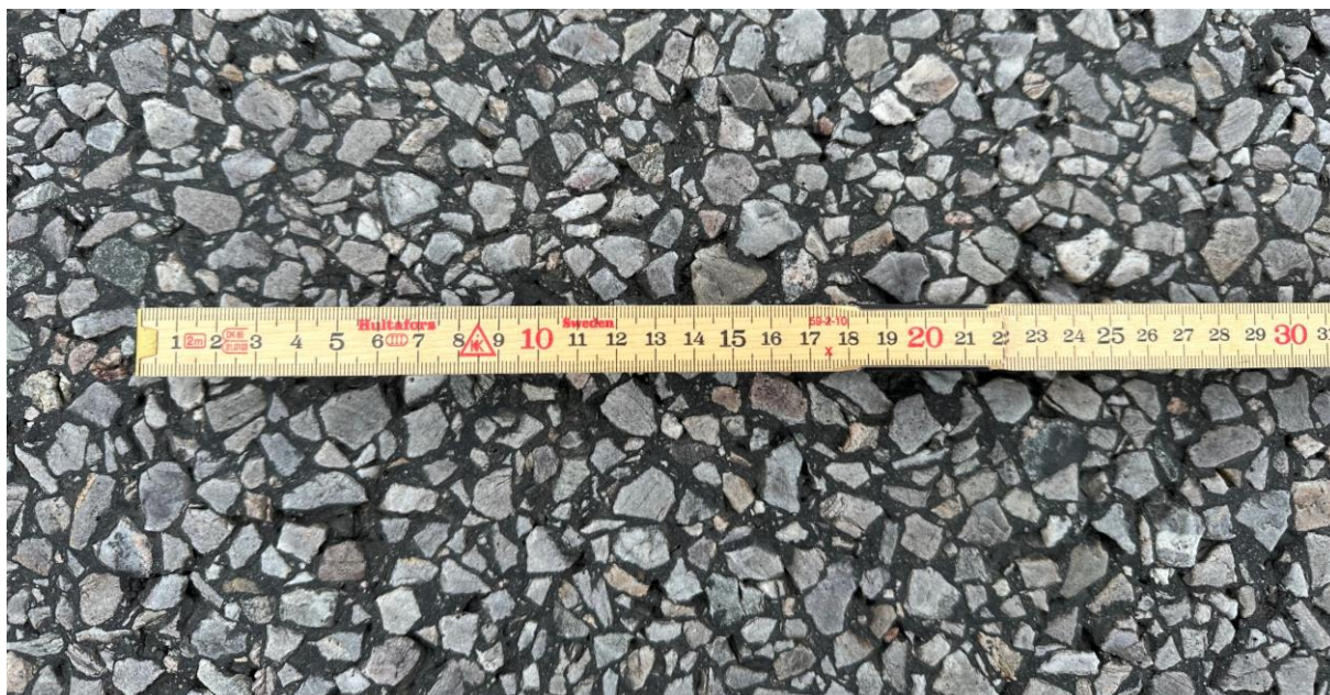
Figur 11. Vägyta vid mätplatsen vid Säve.
